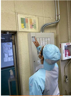
受信盤にて場所の特定確 指示だしを行う管理者
